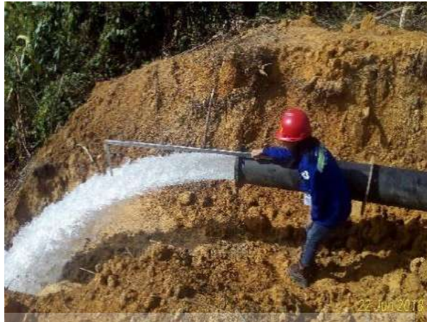
Gambar 4.9. Proses pengukuran debit aktual outlet pompa
